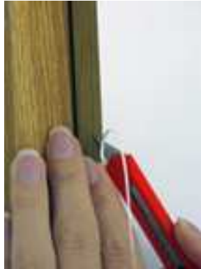
Überstehende Reste abschneiden
